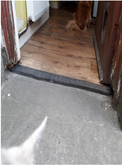
Photo 1: Rotten door frame
